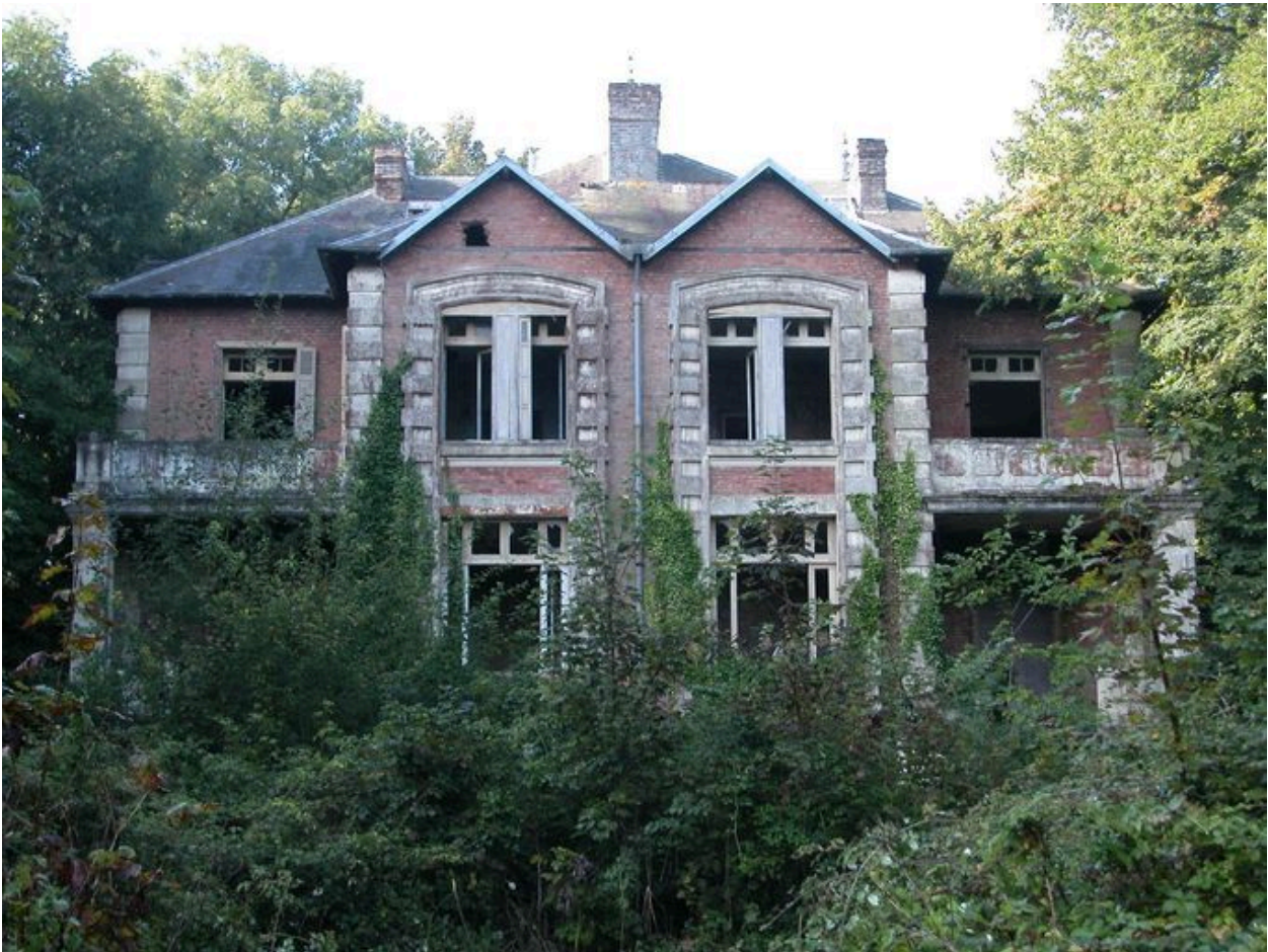
Maison, avenue Romain-Michel, détruite en cours d'étude.
