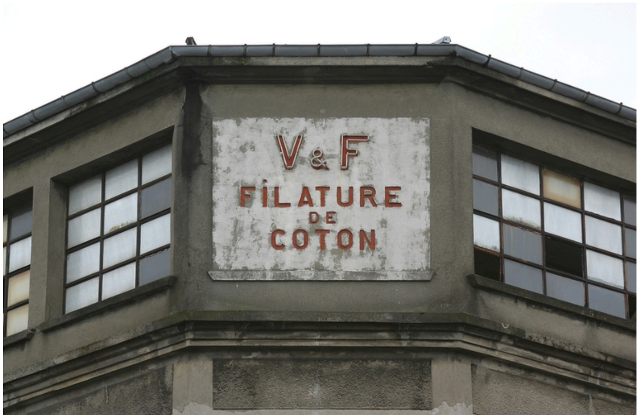
Façade de l'usine : détail.
