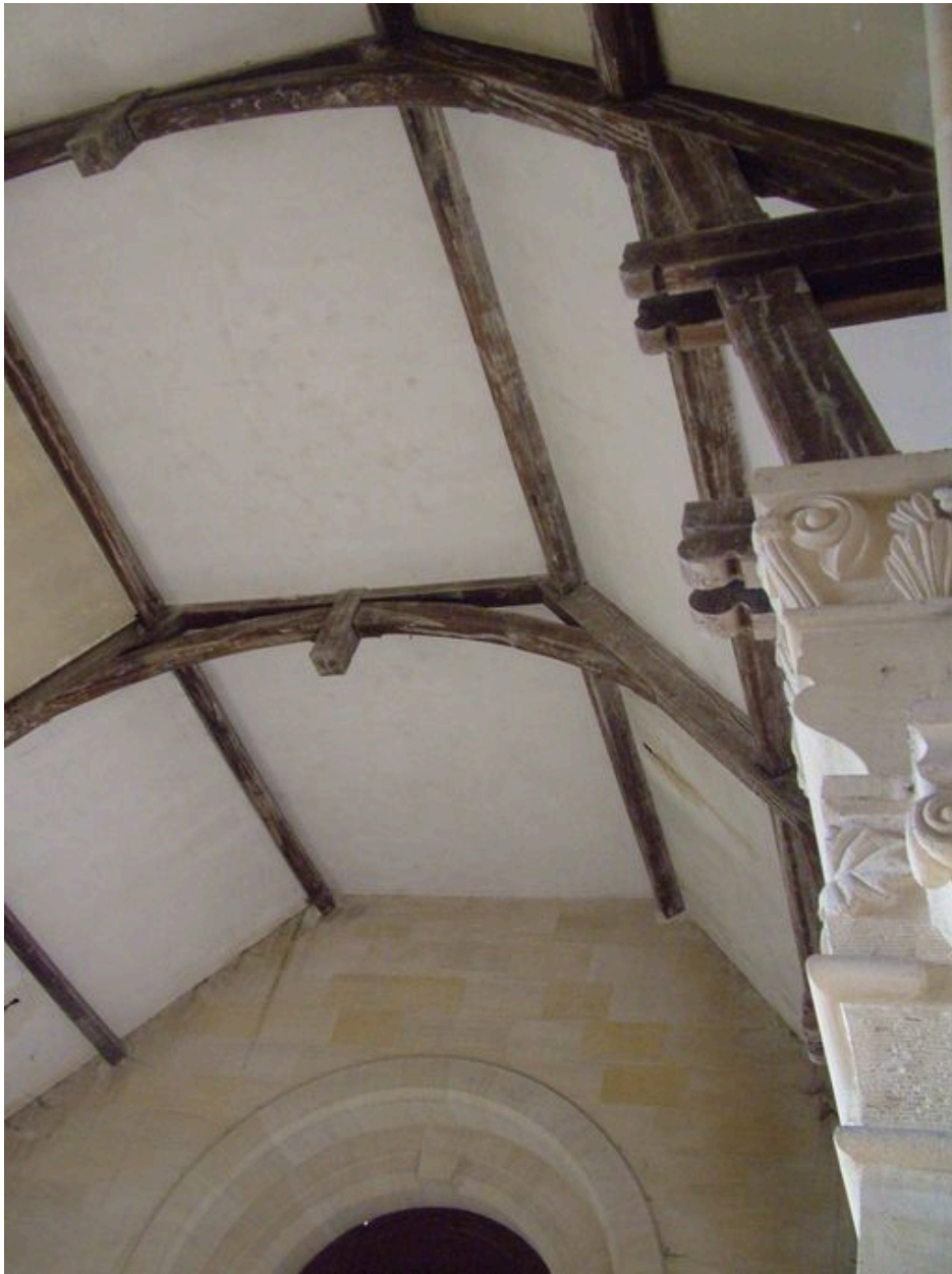
Vue de la charpente.
