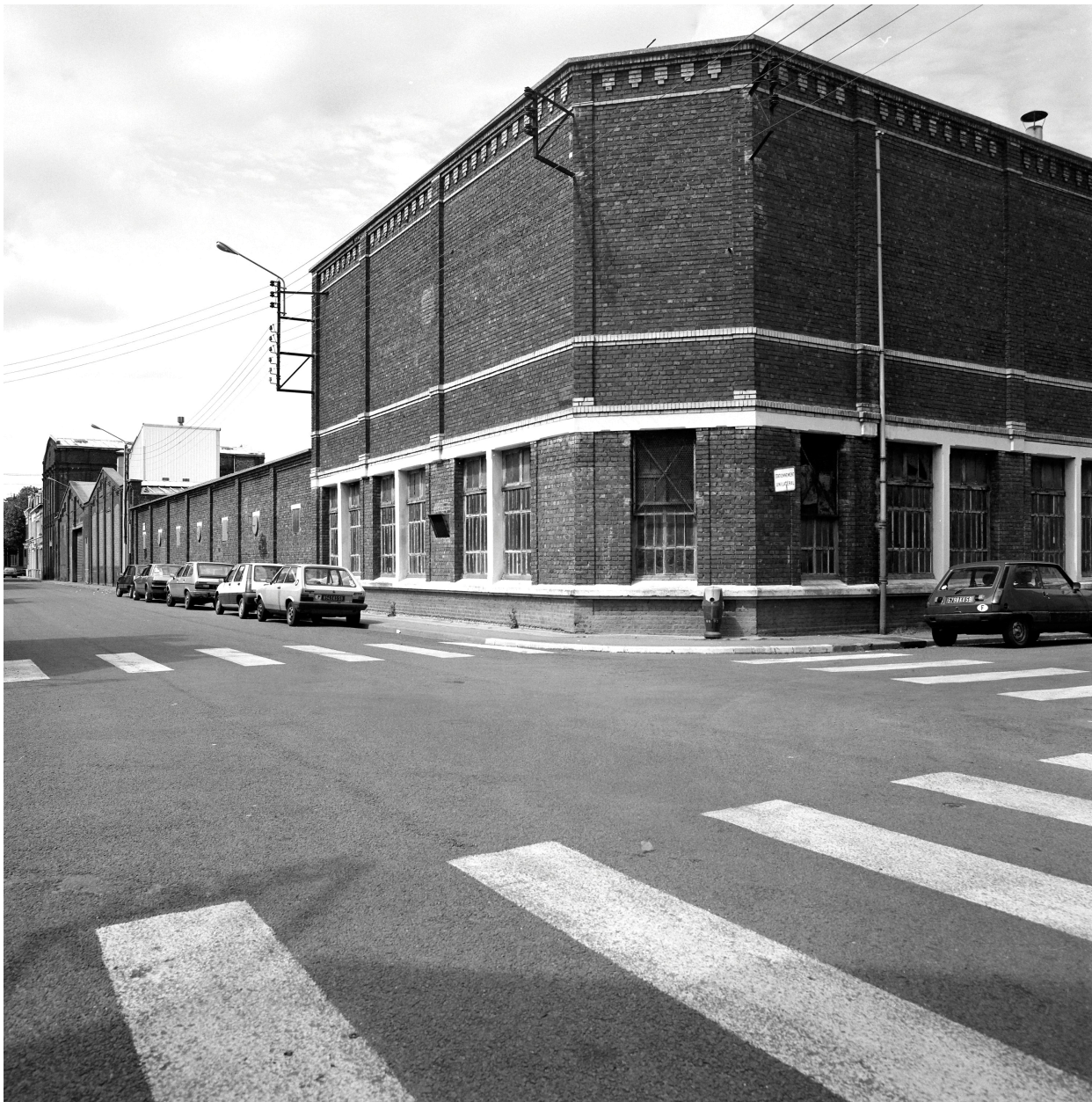
Enfilade. Vue prise vers le nord-est, depuis la rue de Strasbourg.
