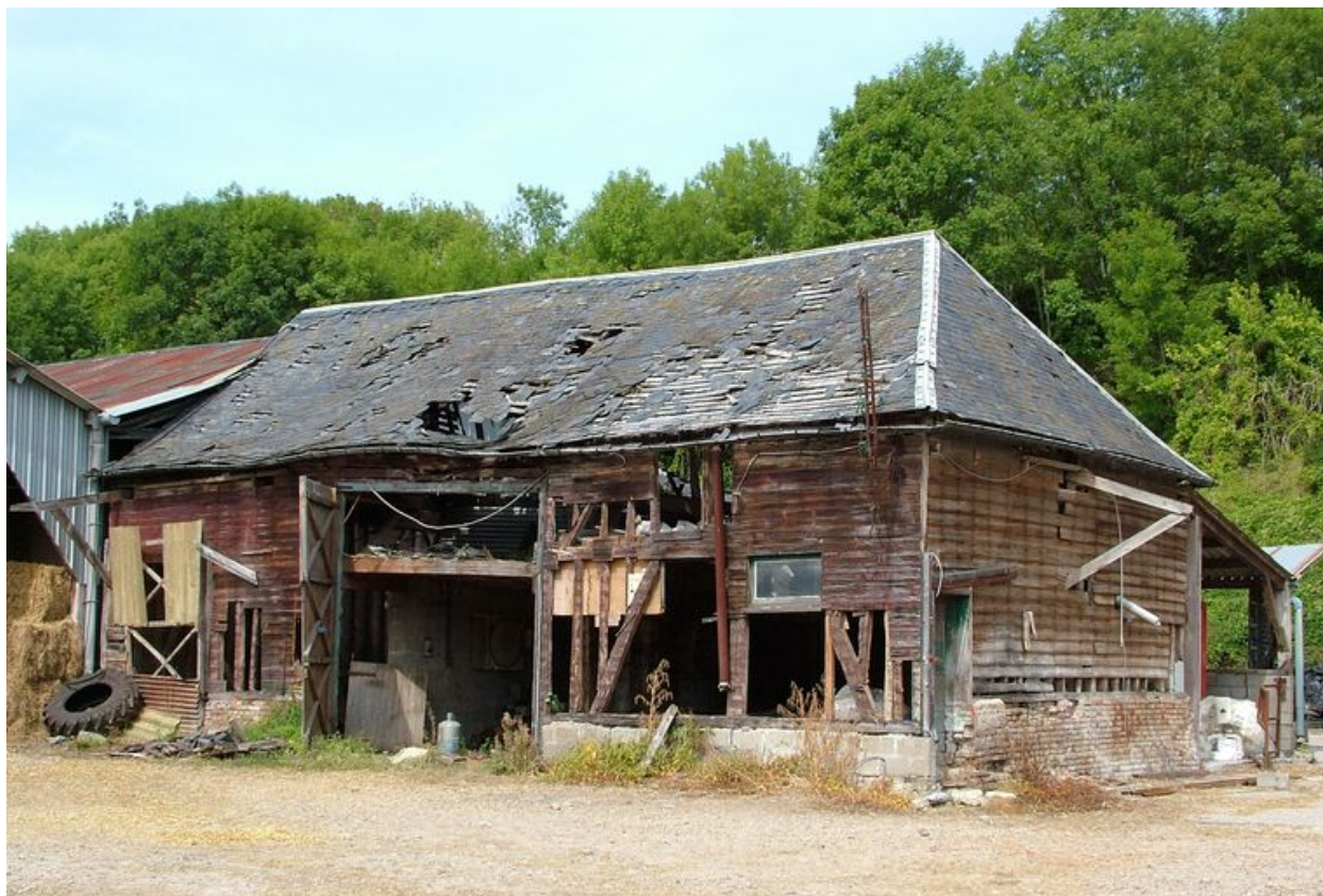
Vue de la grange en fond de cour en essentage de planches.
