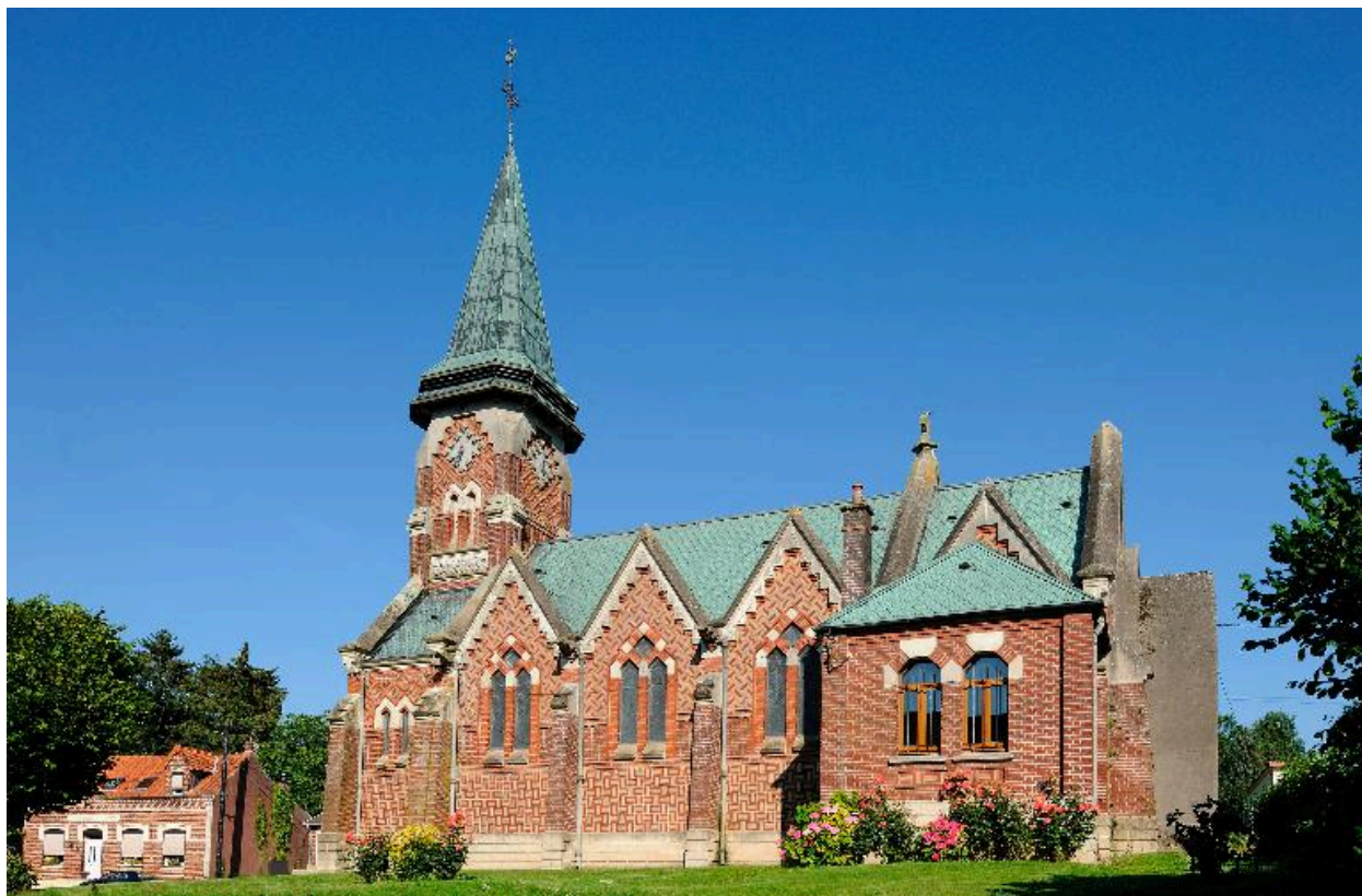
Vue de la façade sud
