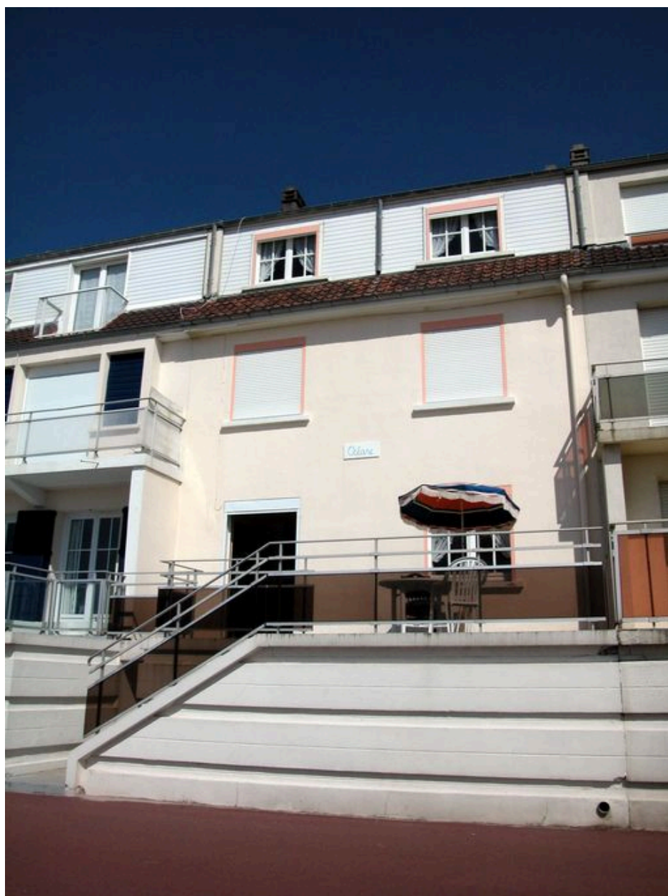
268 boulevard maritime sud (Océane), façade sur mer.
