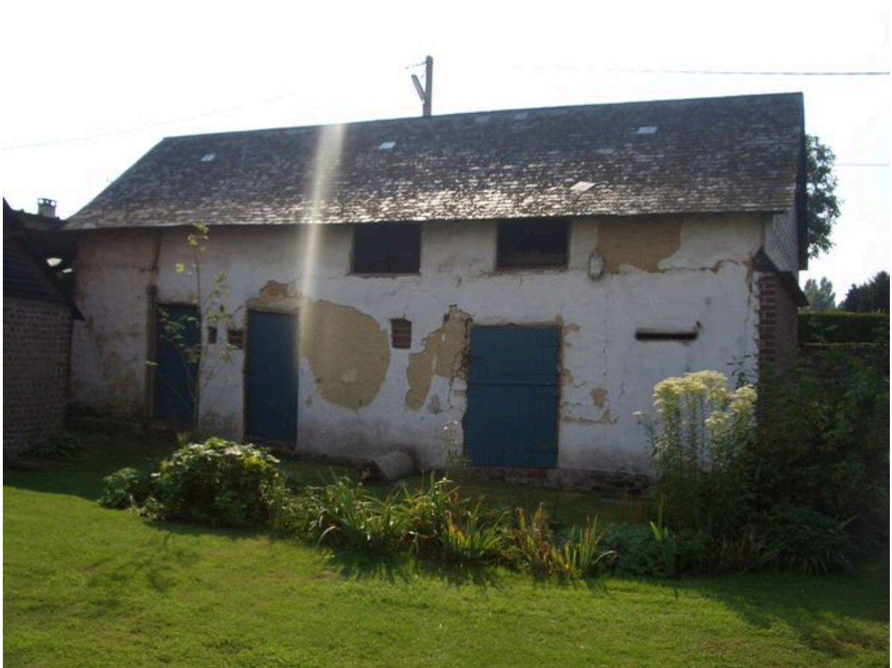
Vue des écuries longeant la rue.
