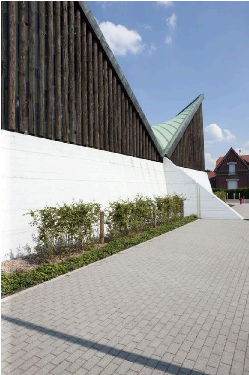
Vue de trois quart de l'élévation sud.
