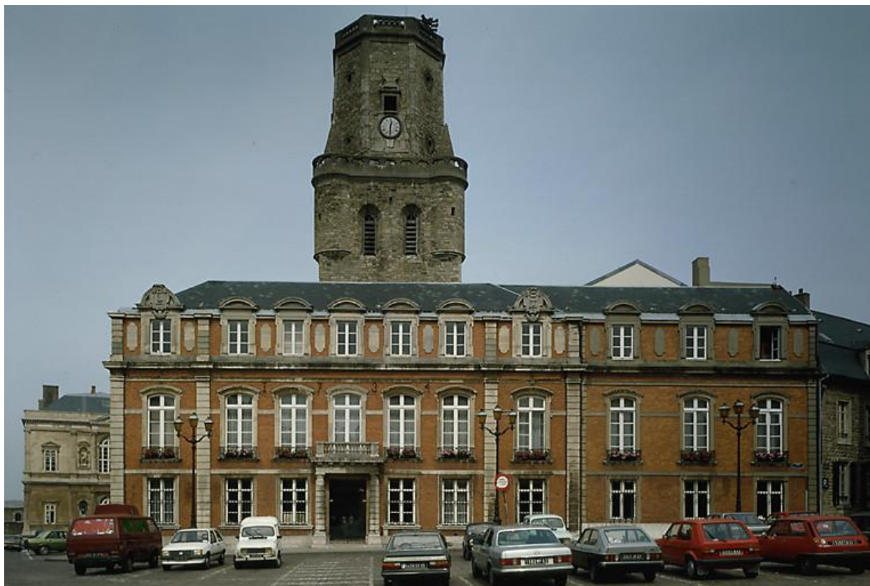
Façade sur place Godefroy de Bouillon.
