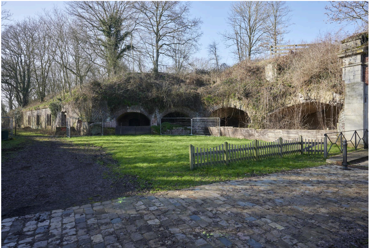
Front de gorge. Vestiges de casernes, vers l'ouest.
