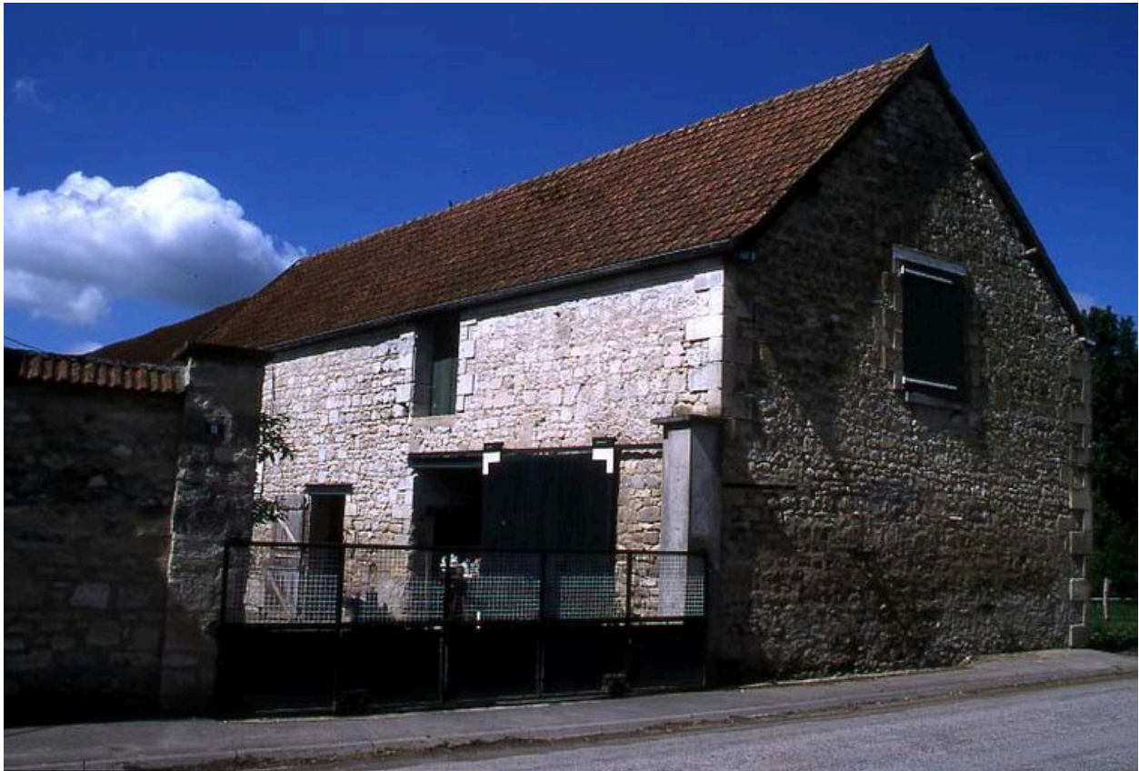
Vue de la grange.
