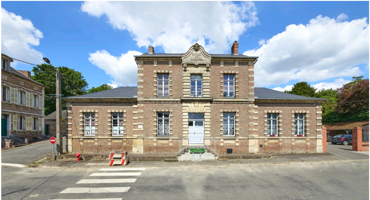
Vue de l'ancienne école des garçons, depuis le sud.
