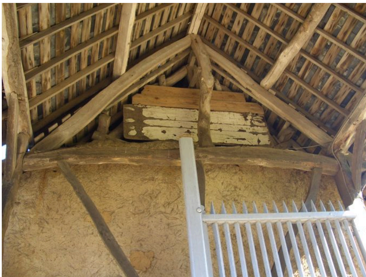
Vue détaillée de la charpente du passage couvert.
