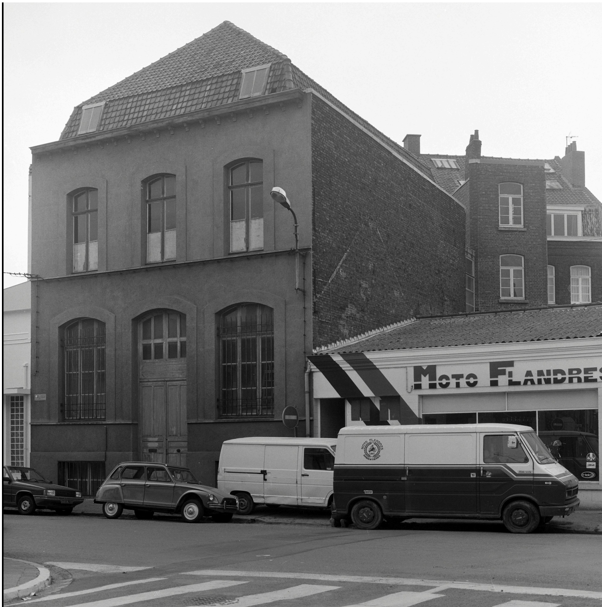
Élévation postérieure, rue Robert Schuman.
