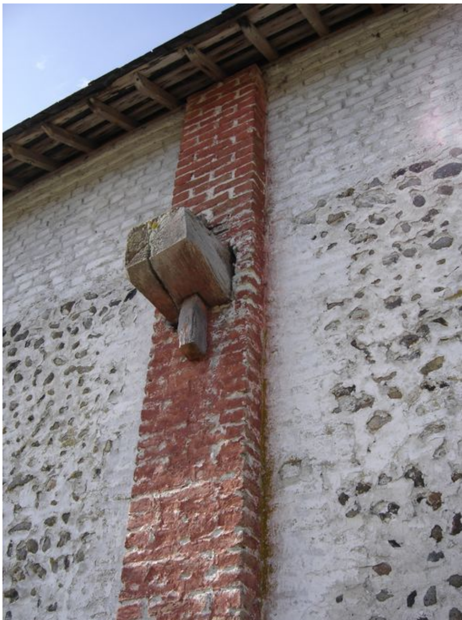
Détail d'un tenon d'ancrage.
