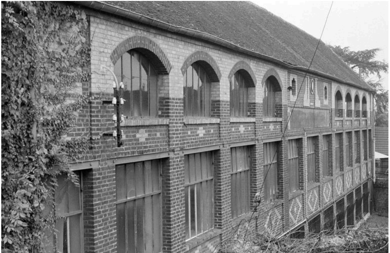
Atelier de fabrication, façade est, vue vers le nord.
