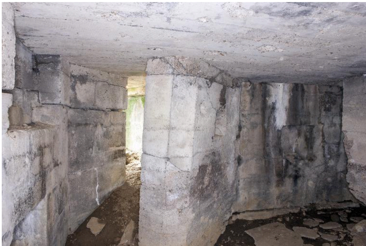
Vue intérieure, entrée en chicane ouest
