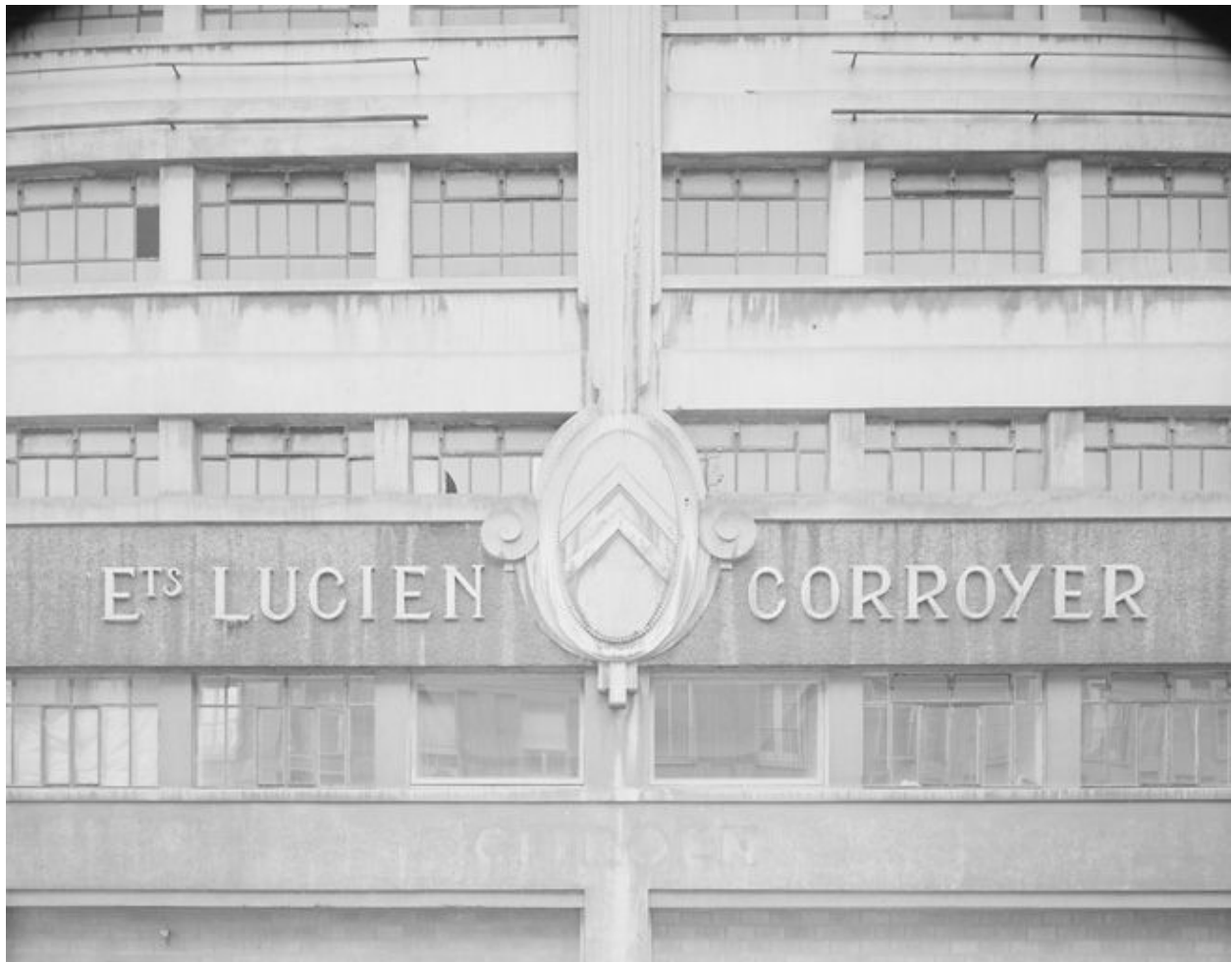
Vue du décor porté ornant l'ancienne entrée principale sur la façade nord.
