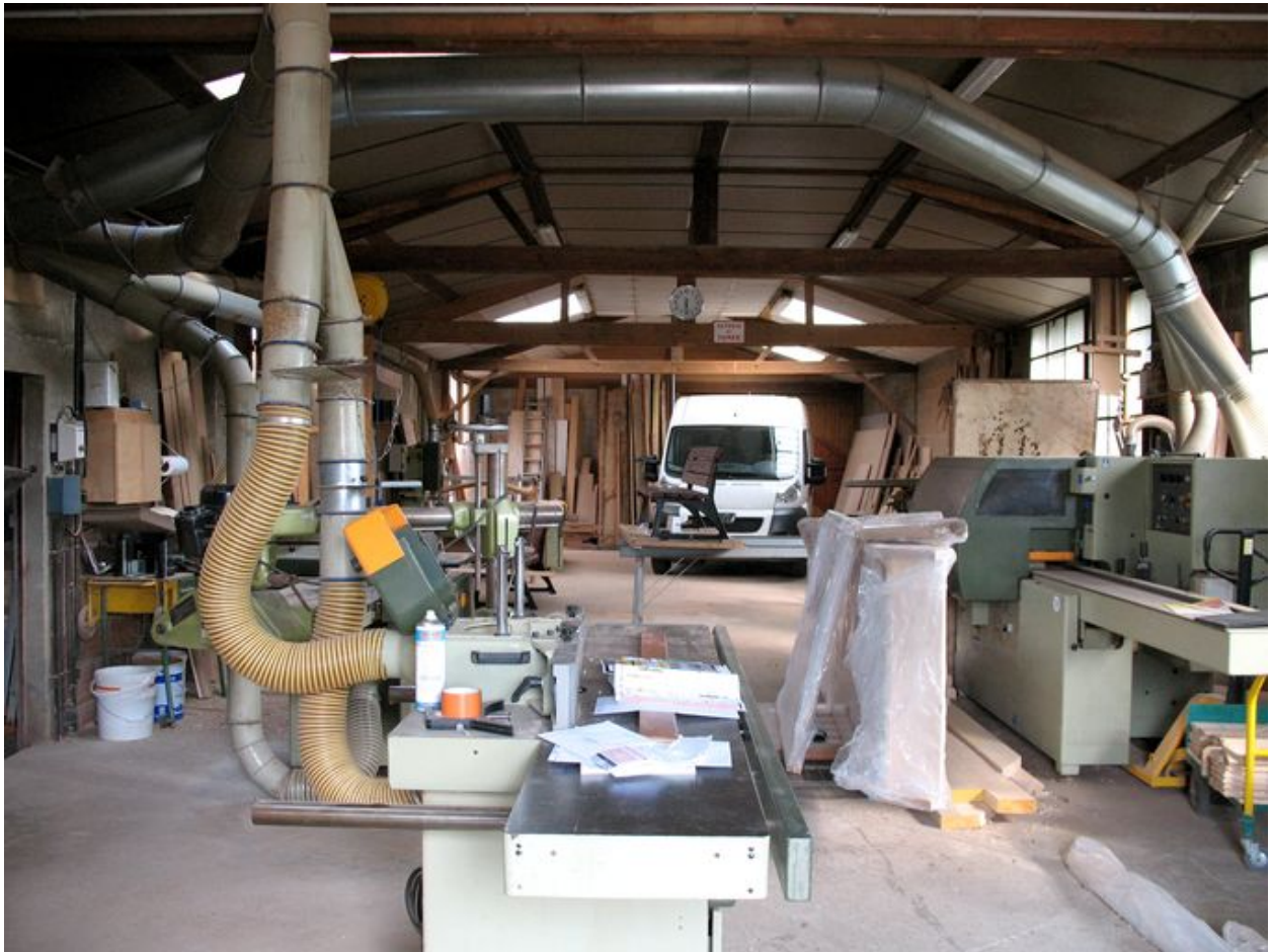
Intérieur de l'atelier de menuiserie.
