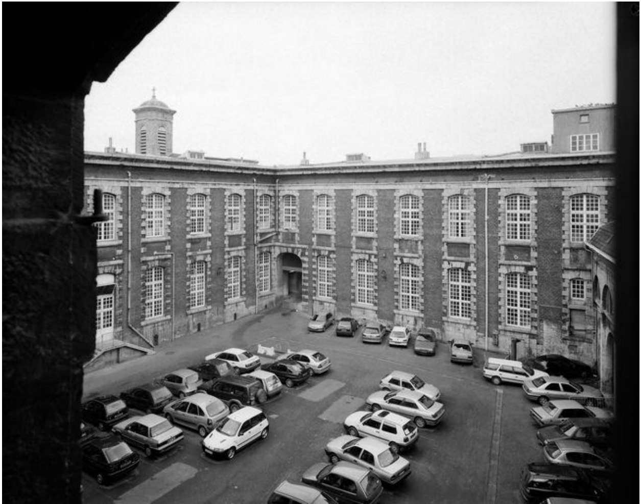
Cour des services, vue générale en regardant vers le corps de bâtiment fermant la cour sur l'arrière.
