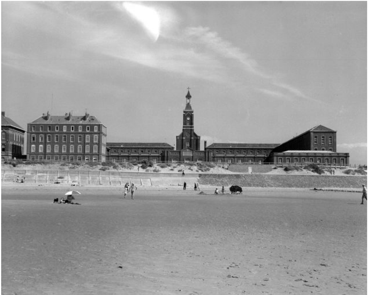
Corps de logis principal, élévation antérieure donnant sur la plage, vue générale prise de face.
