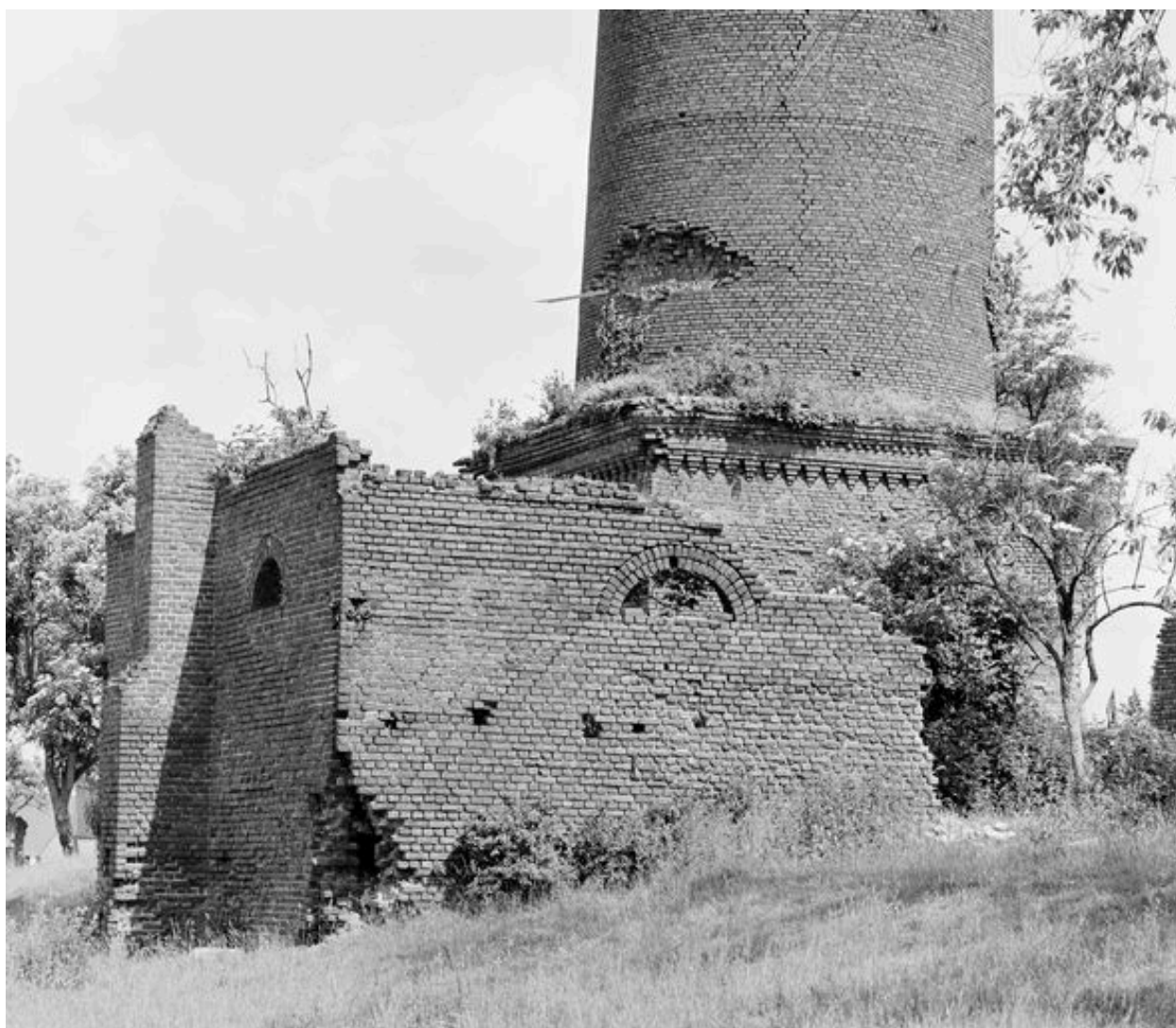
Socle de la cheminée d'usine.
