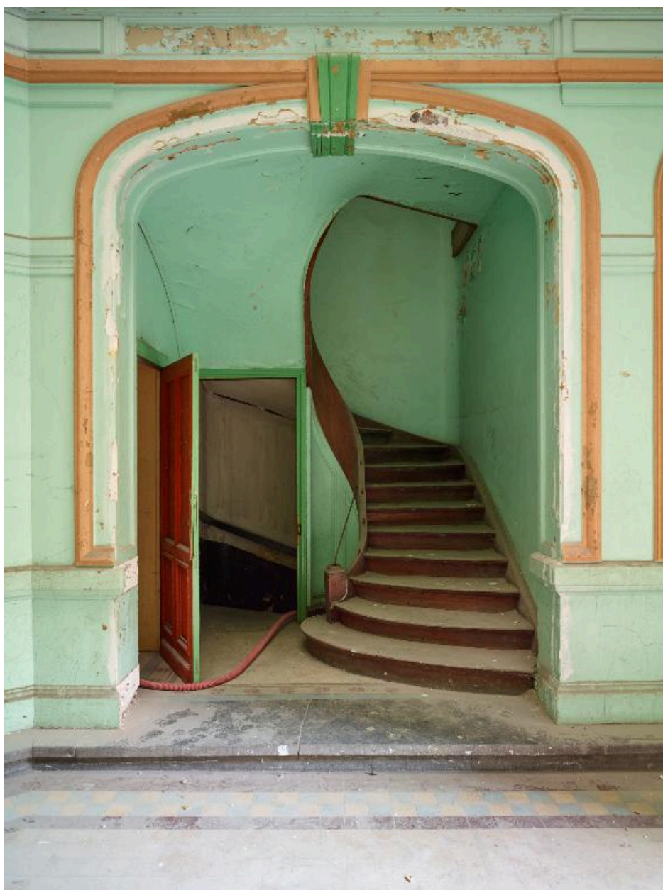
Bâtiment central. Vue générale de l'escalier nord du vestibule.
