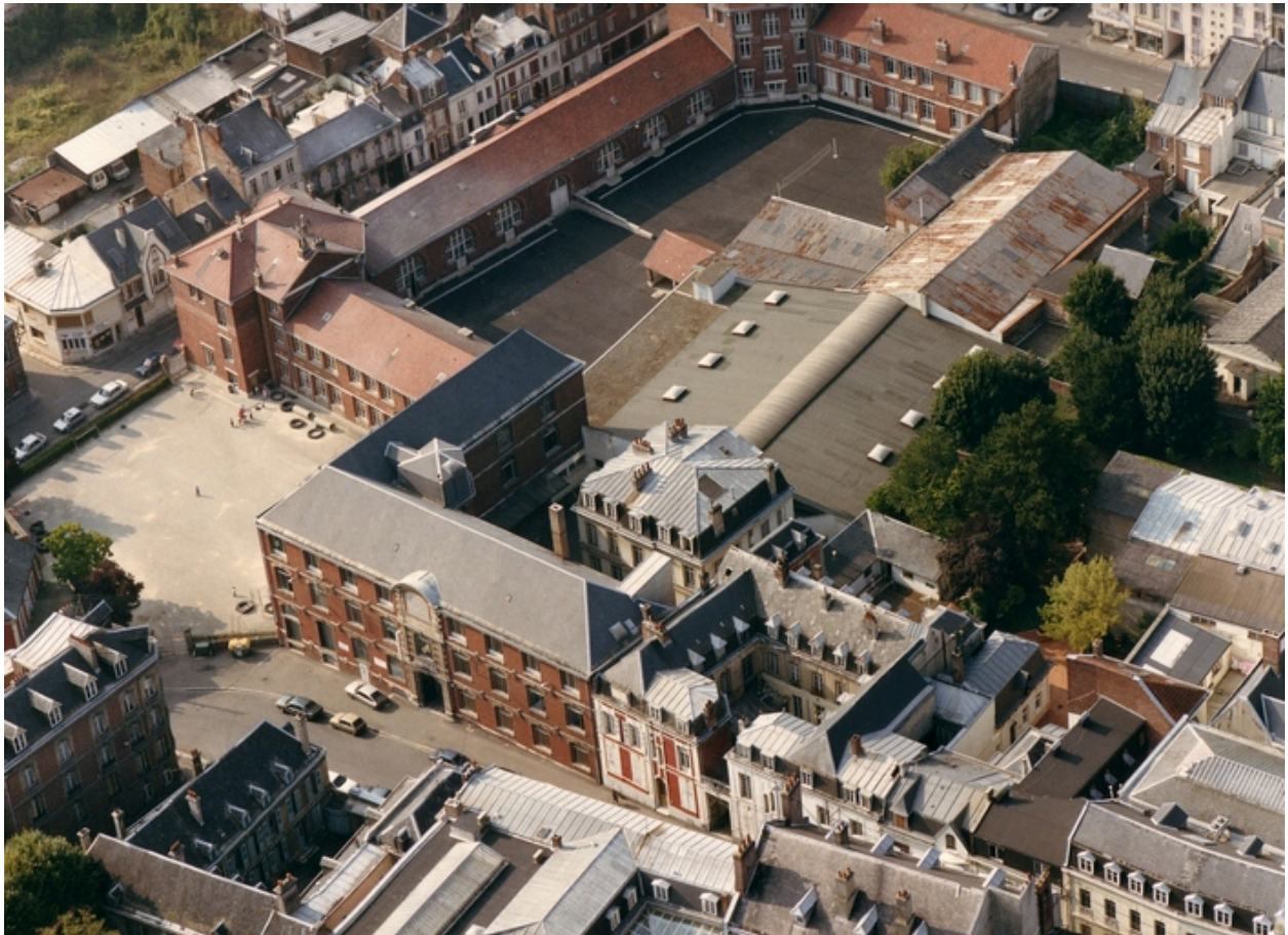
Vue aérienne du site (AP).
