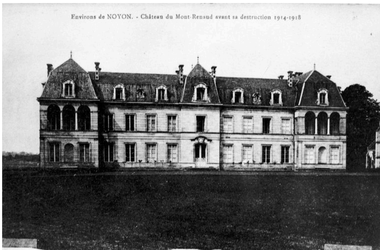
Elévation postérieure du château avant 1914 (AP).
