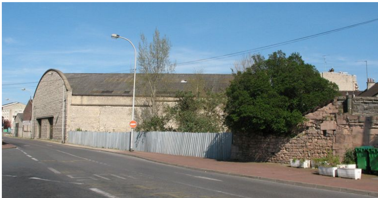
Vue générale des entrepôts depuis la gare.
