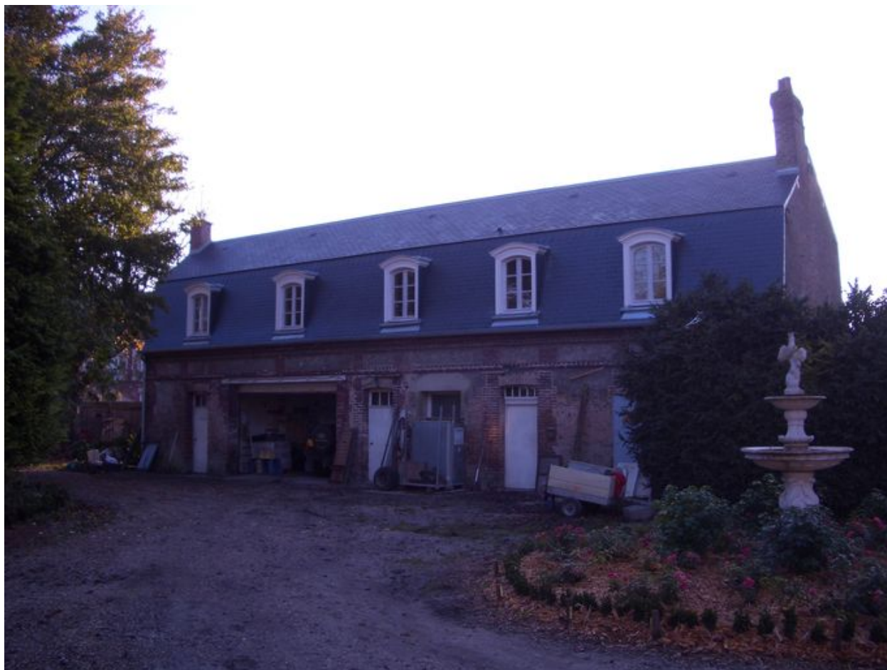
Vue postérieure de la conciergerie.
