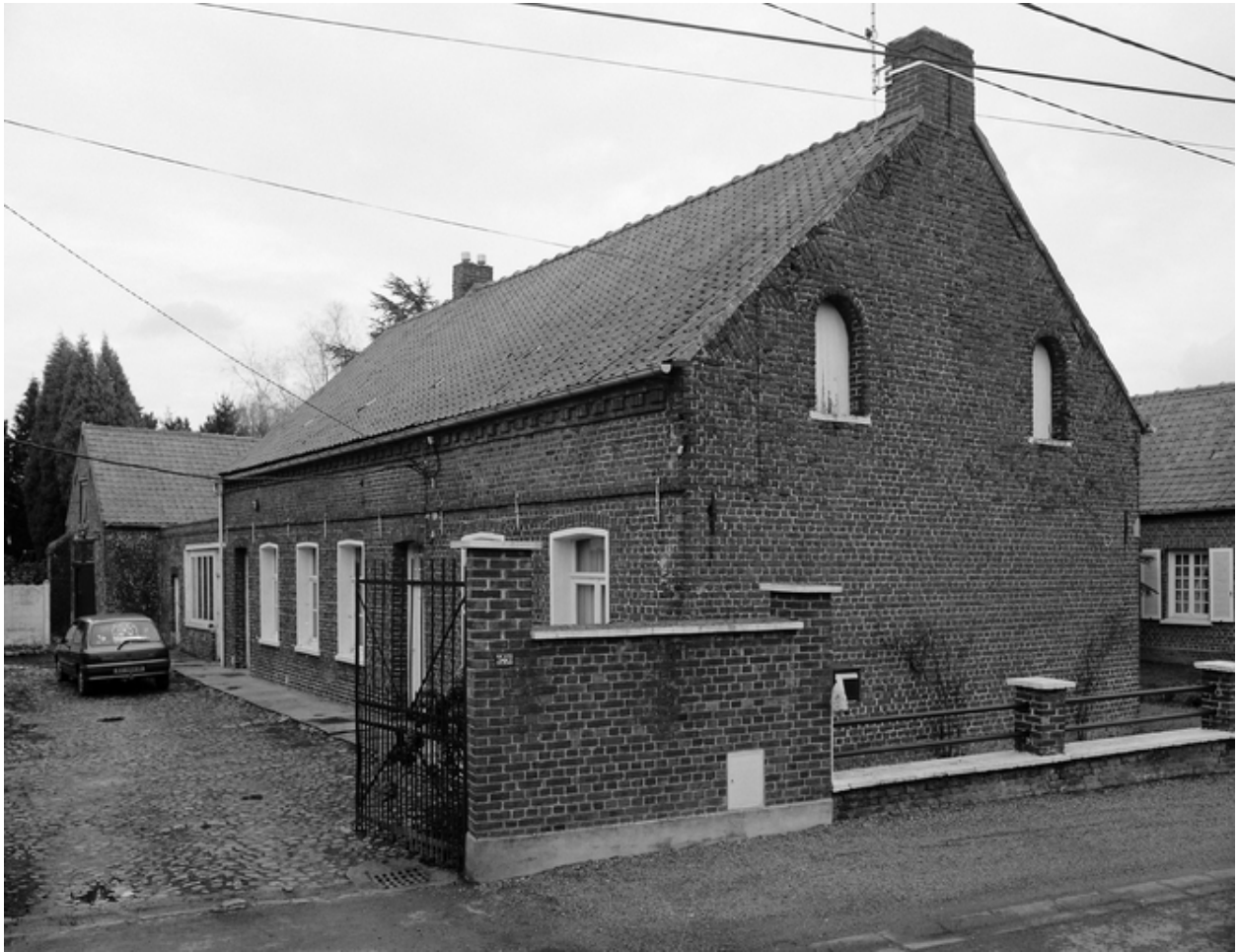
Vue générale du logis depuis la rue.
