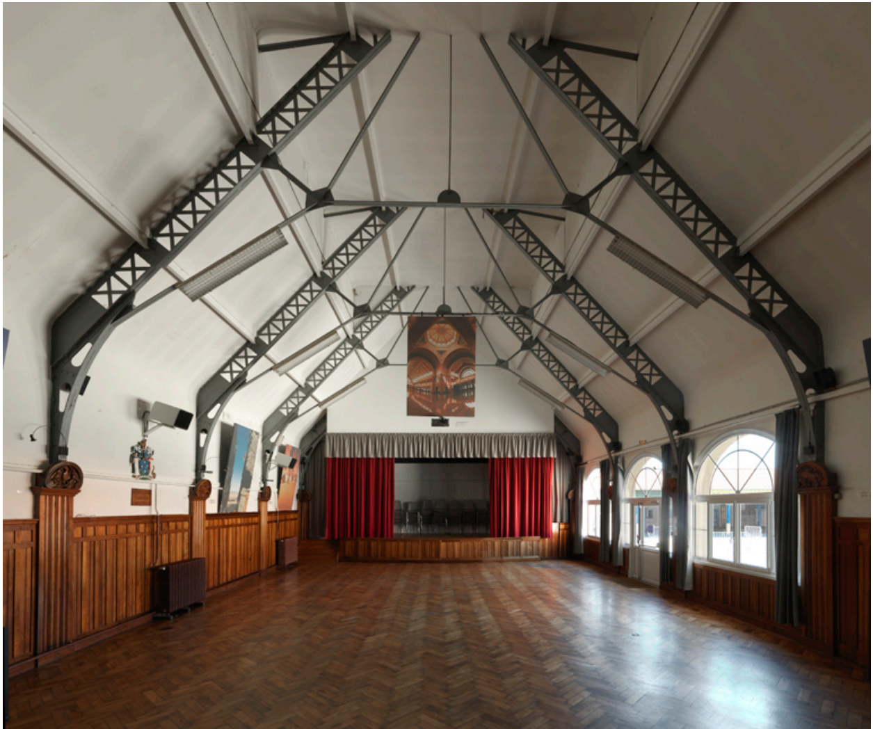
Vue intérieure de la salle des conférences. La charpente métallique et la scène.
