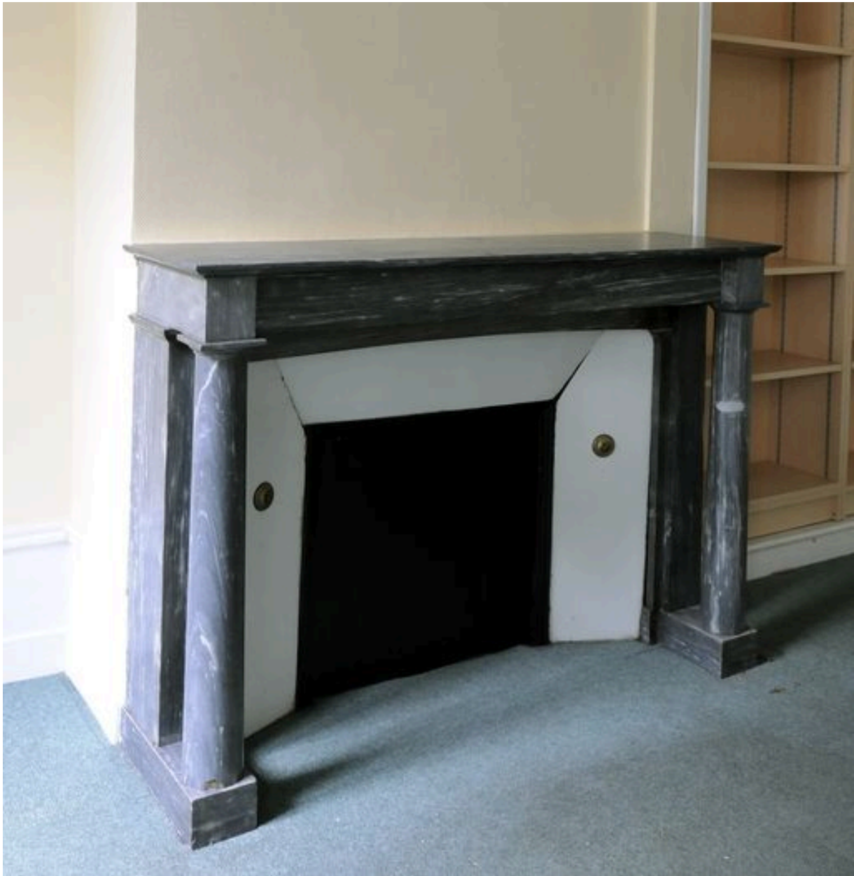
Cheminée de la chambre (sur rue) du deuxième étage.
