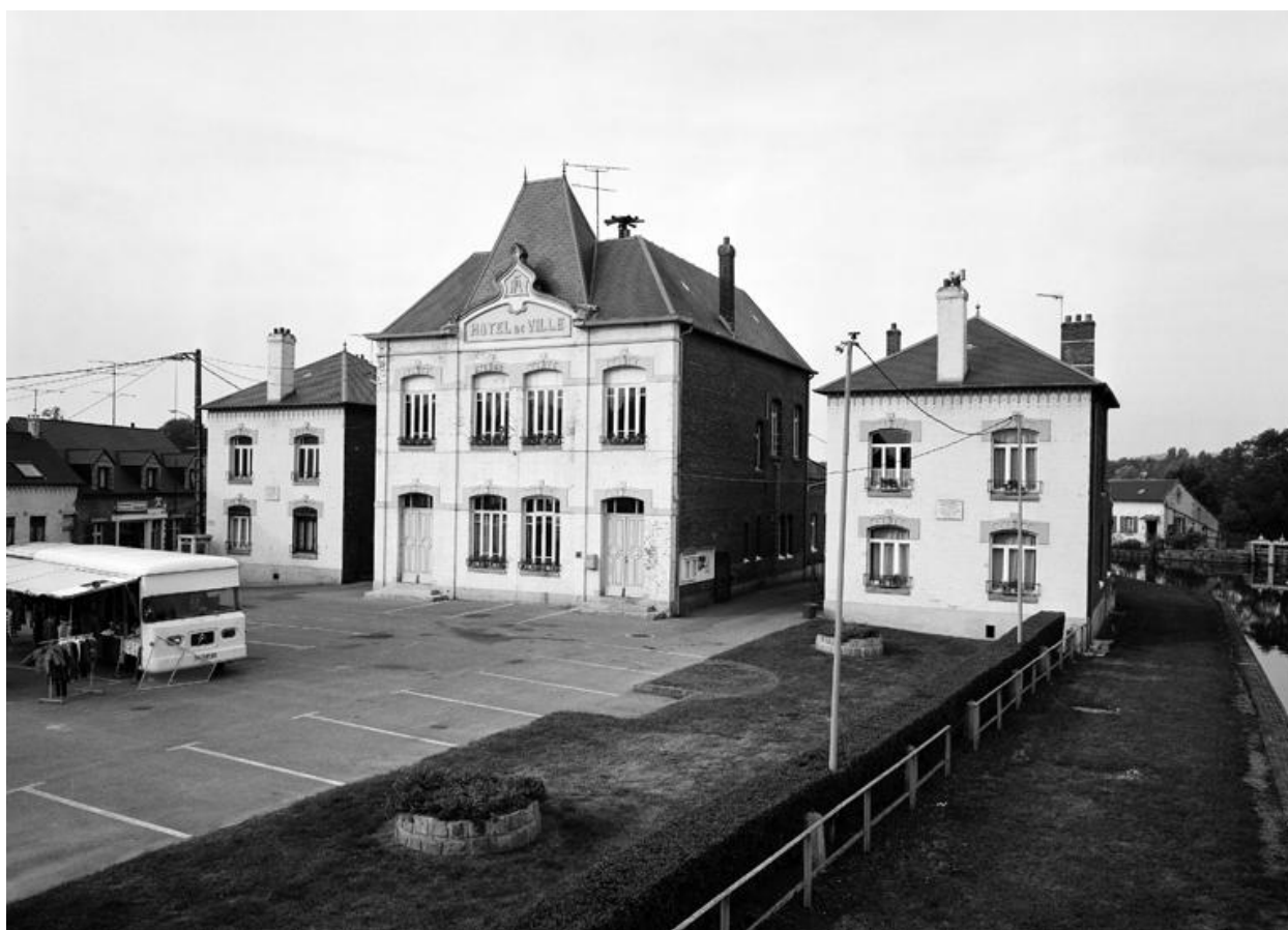
Vue d'ensemble de la façade.
