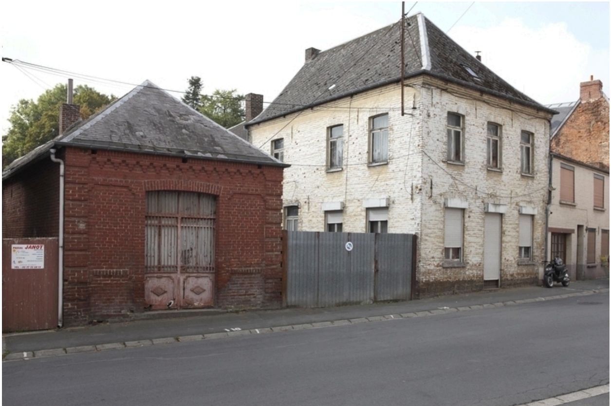
Vue générale de la boucherie et de l'habitation, depuis la rue.
