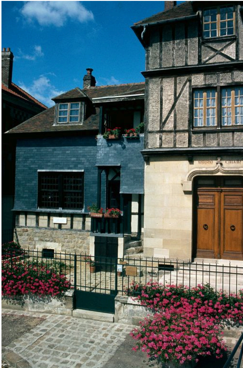
Vue partielle de l'élévation antérieure.
