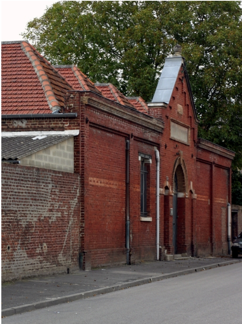
Les ateliers de 1907 : façade antérieure.
