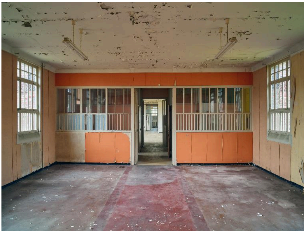
Bâtiment d'hospitalisation dit pavillon D9, 1er étage, enfilade de salles de malades.
