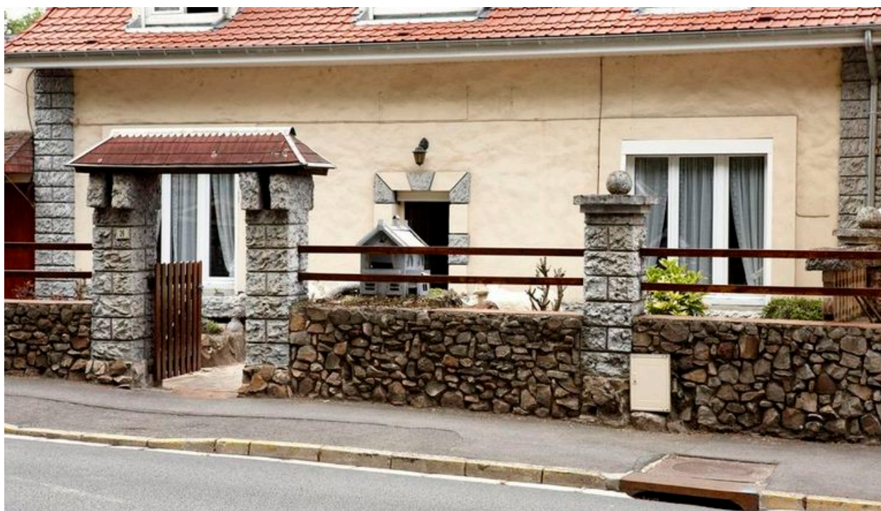
Vue partielle de la façade.
