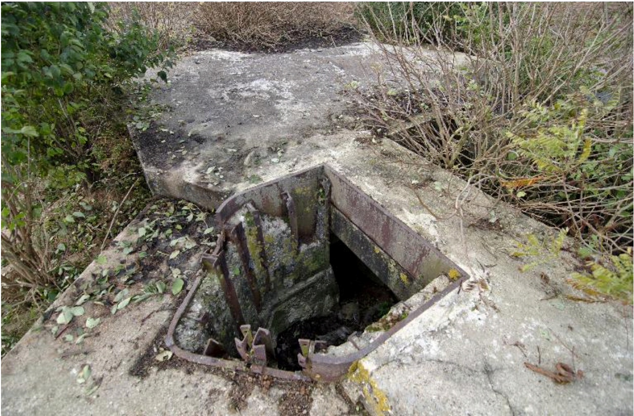
Vue plongeante dans l'observatoire cuirassé sud, privé de son couverture
