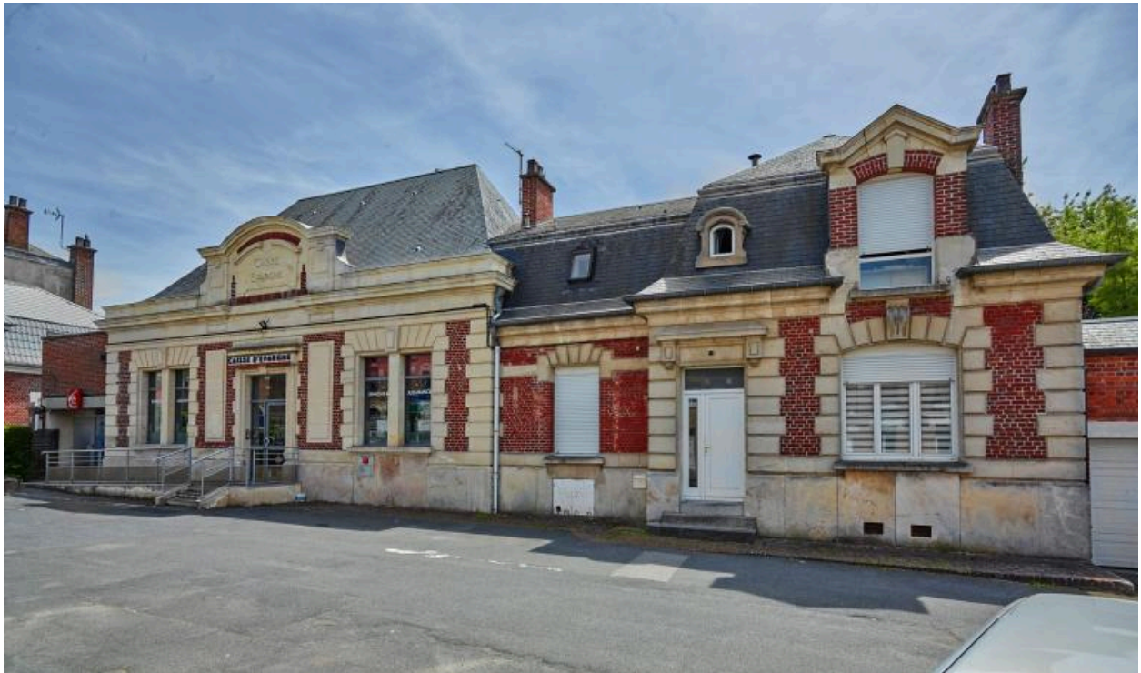
Vue générale de la façade principale.
