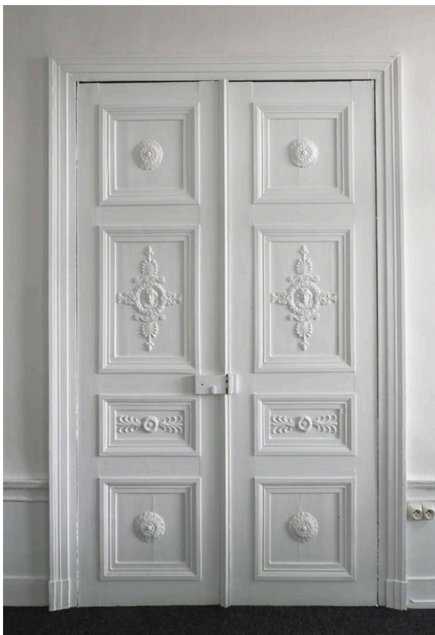
Porte de séparation entre la chambre (sur rue) et le cabinet du premier étage.
