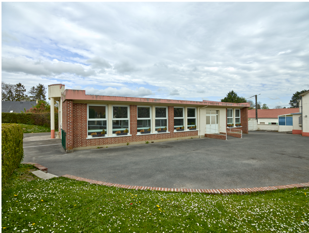
Salle communale, depuis le sud.
