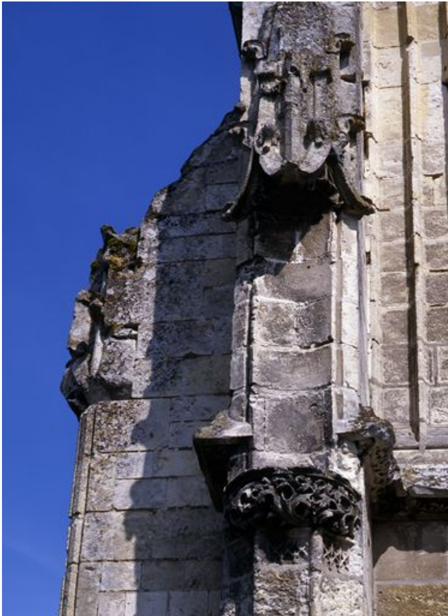
Niche des contreforts.
