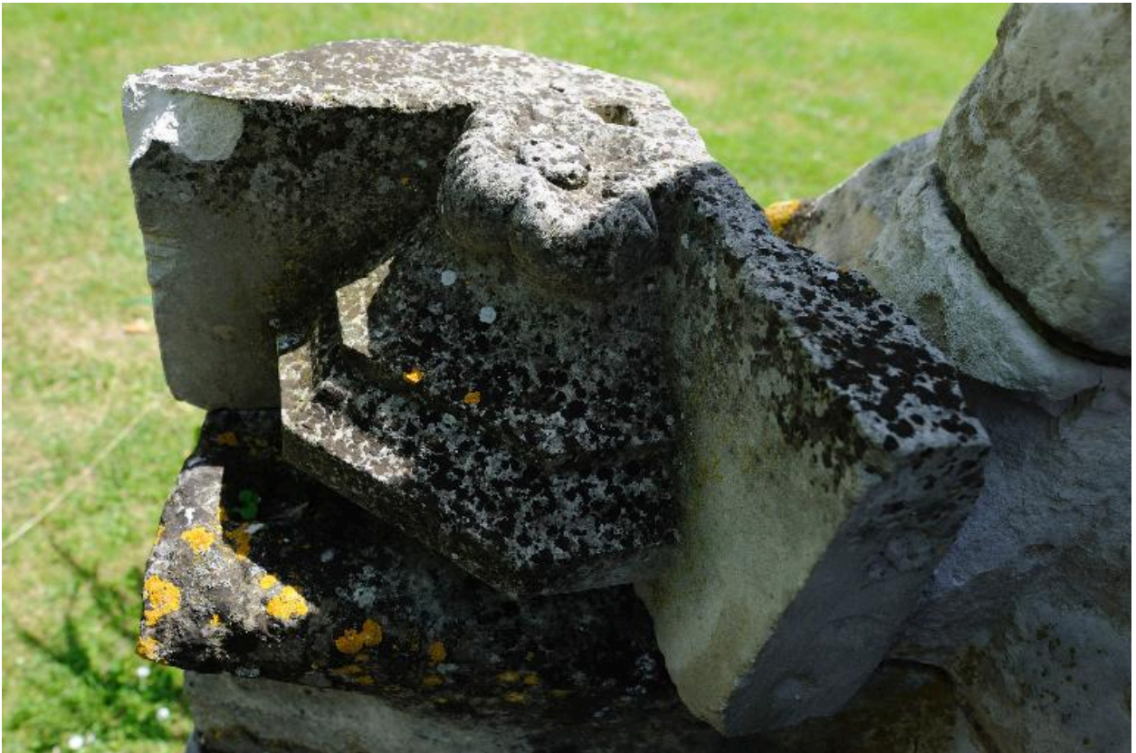
Elément d'appareil avec culot remonté dans l'ancienne église priorale.
