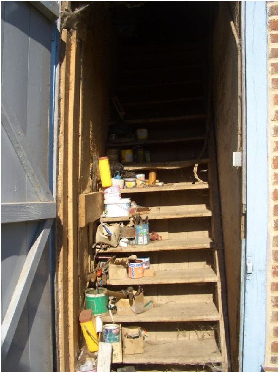
Vue de l'escalier de meunier menant au grenier, situé en façade sur cour.
