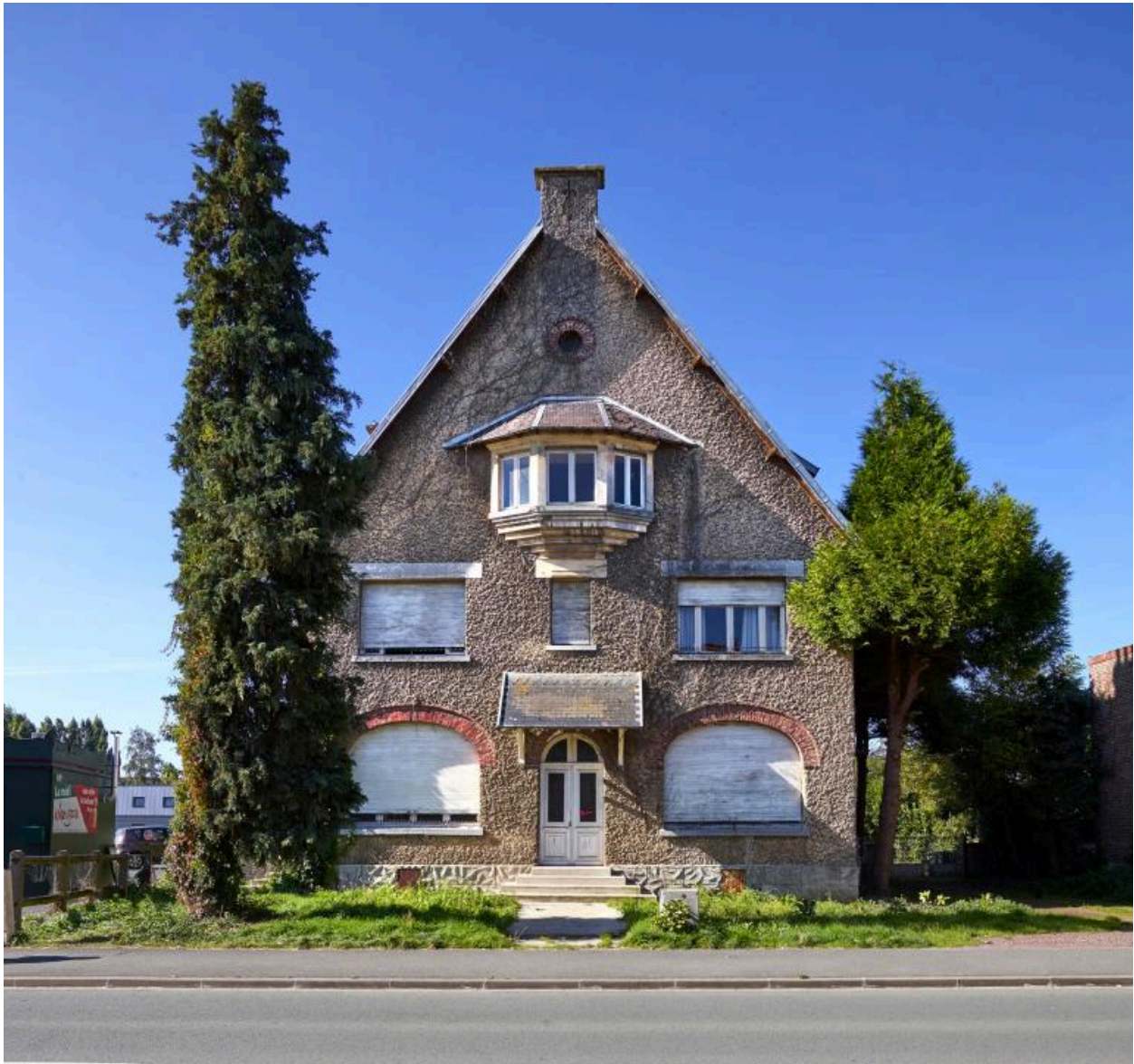
Vue générale de la façade principale depuis la rue du Faubourg de Péronne.
