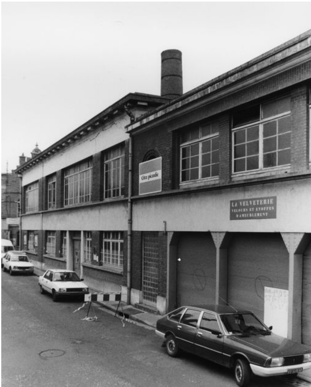
Vue partielle, flanc est.
