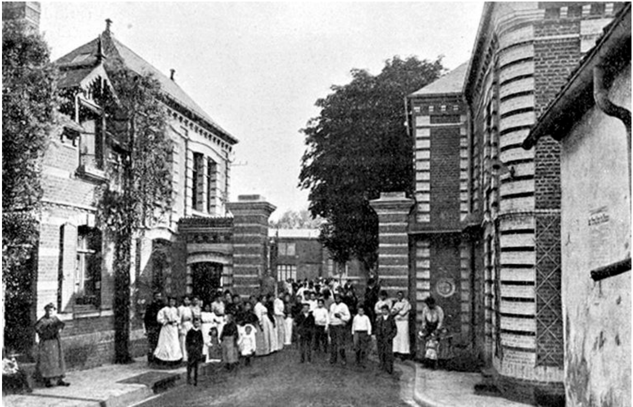
Entrée de l'usine (Notre Picardie, n°32, 1er février 1909).
