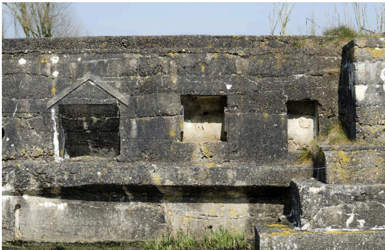
Elévation sud, banquette de tir et niches à munitions
