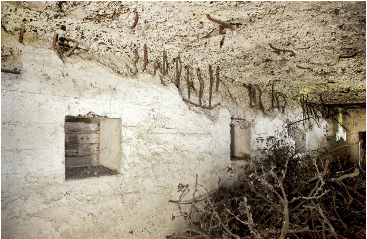
Vue intérieure, niches à munitions
