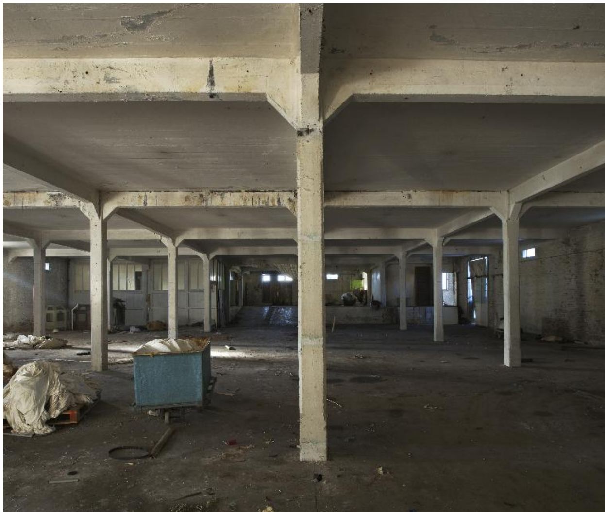
Intérieur de l'entrepôt des matières premières.
